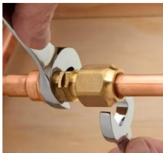
Rys. 22: Procedura montażu przyłączy wody do węžownicy chłodzącej
